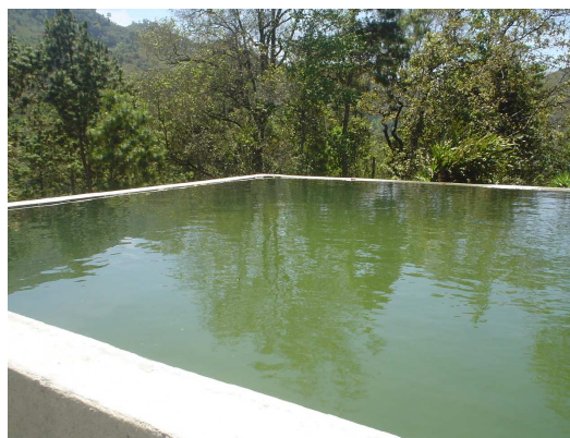
Figura 39. Tanque de reserva de agua para el beneficio de Nochan.
