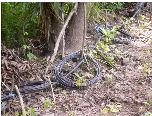
Figura 17. Mangueras abandonadas del sistema de minirriego.
