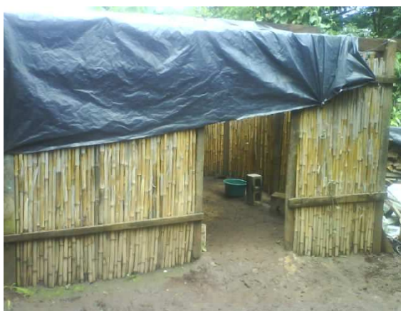
Figura 3: Cocina con paredes construido con cañas de maíz
