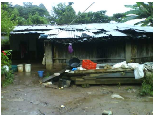
Figura 58: Vista parcial de la vivienda y la cocina
