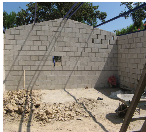
Figura 37: Construcción de la ampliación del hogar.
