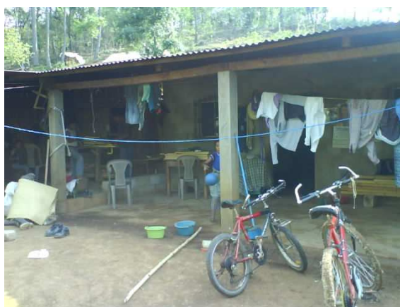
Figura 47: Vista parcial de la vivienda
