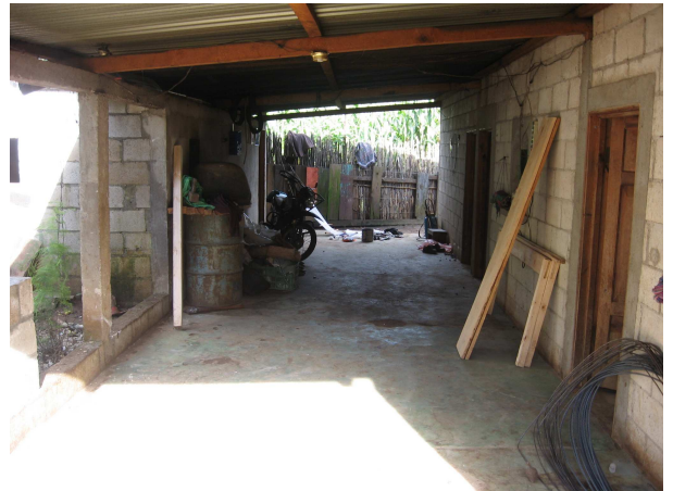
Figura 15: Casa habitacional con 3 cuartos y cocina construidos a base de block
