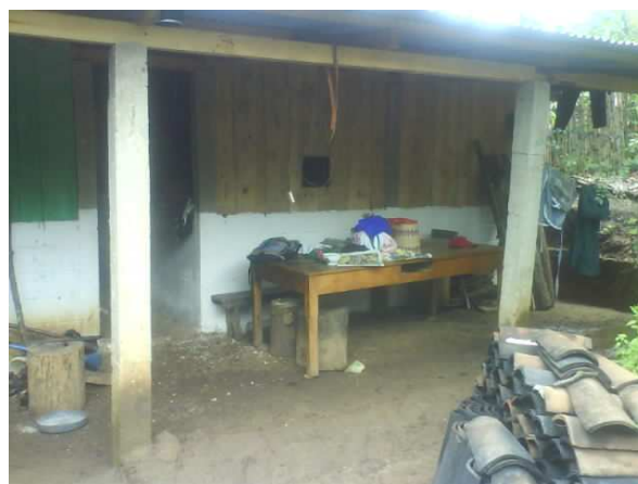
Figura 4: Casa de dos cuartos construido a base de block, lepas de ciprés y lamina
