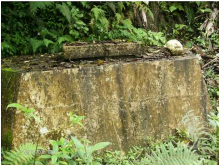
**Figura 4** Tanque de captación del agua entubada, aldea La Gloria.
