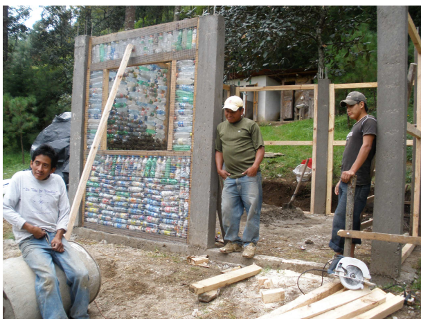
Figura 21. Construcción del centro de acopio para materiales reciclables
