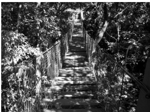
FIGURA 22. Puente de hamaca reconstruido.
