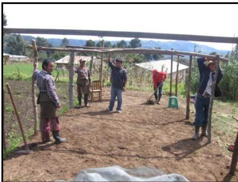
FIGURA 3.3 c. Armado y levantado de paredes de la estructura del vivero. Noviembre 2008.
