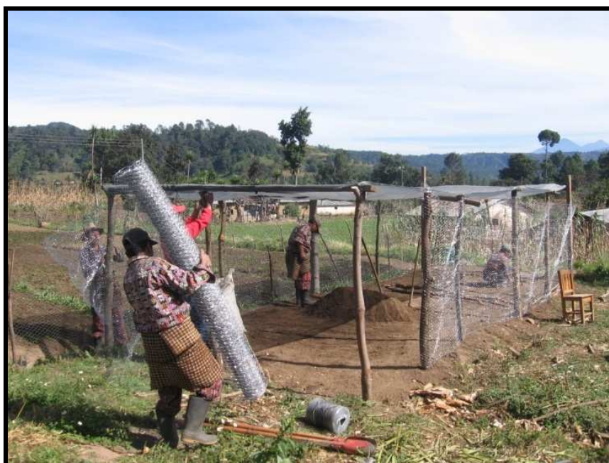
FIGURA 3.4 d. Techado y cercado de la estructura. Noviembre 2008.
