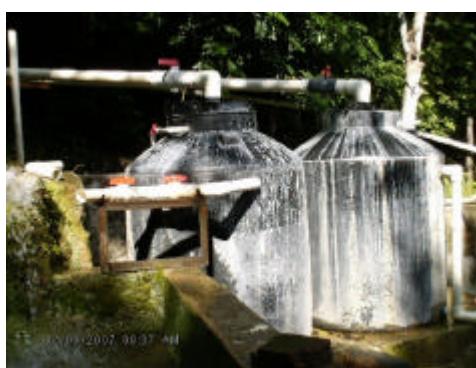
Figura 2.7. A la izquierda se observa el tanque receptor del agua que proviene del manantial y de lado derecho se observan los filtros para aguas duras, que se encuentran a un costado del tanque receptor.
