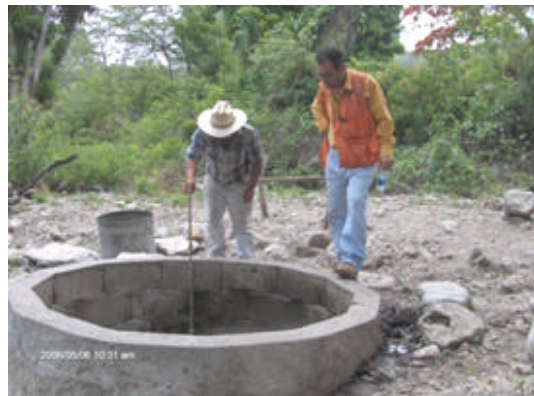
Figura 1.3. Pozo de la finca Sabanetas.
