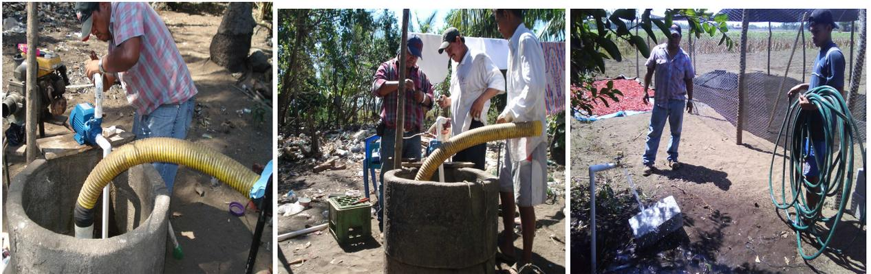
**Figura 11 Instalación de la bomba para sustraer agua del pozo.**
