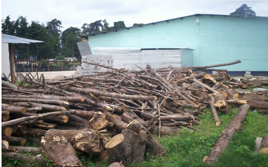
Figura 50 Se puede observar el proceso del corte y tala de arboles para el levantamiento del muro perimetral en la parte trasera de la bodega INDECA Chimaltenango.
