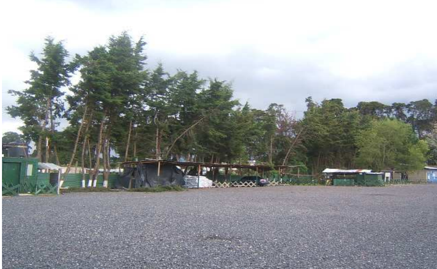
Figura 65 Vista general del área de parqueo y maniobras numero dos con la aplicación del tendido de piedrín.
