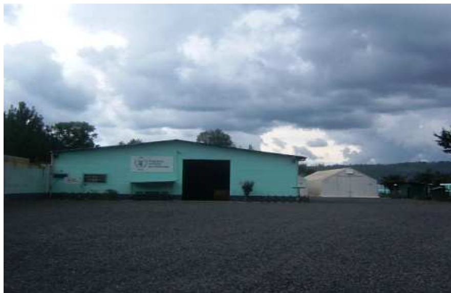
Figura 59 Condiciones en la que actualmente se encuentra el predio de áreas de parqueo y maniobras en el Año 2,009.
