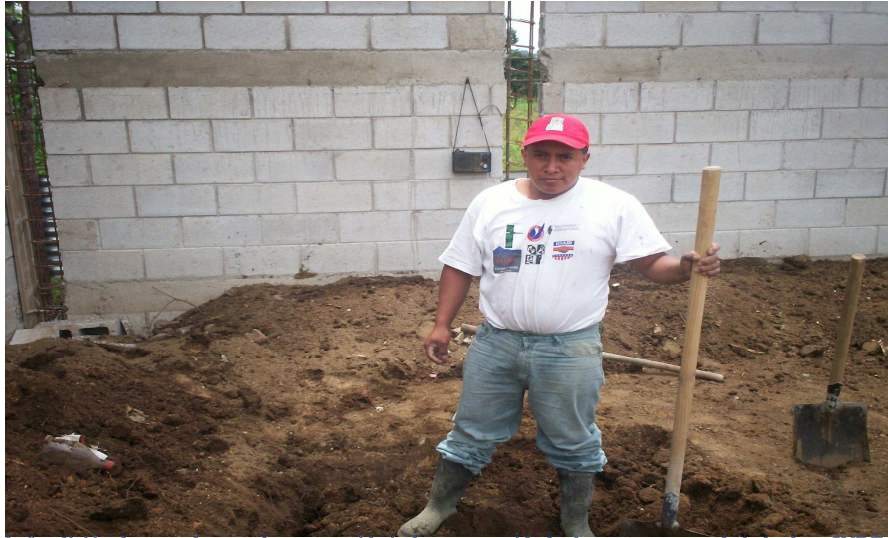
Figura 52 Proceso de fundición de paredes y columnas que brindaran seguridad a la parte trasera de la bodega INDECA Chimaltenango.
