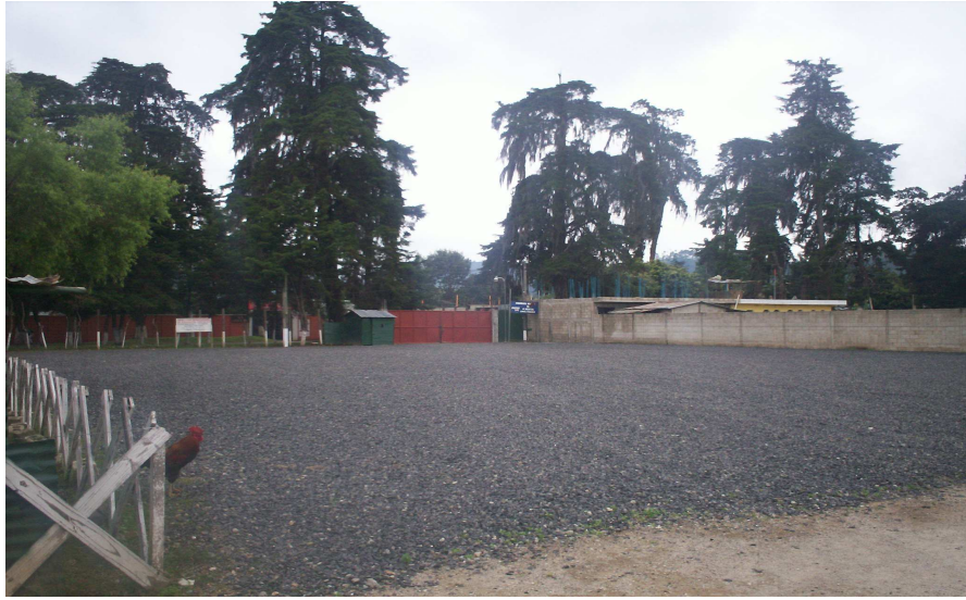
Figura 63 Trabajos finalizados en el área de parqueo y maniobras número uno, nótese la aplicación del tendido de pedrín, nivelación y compactación del terreno.
