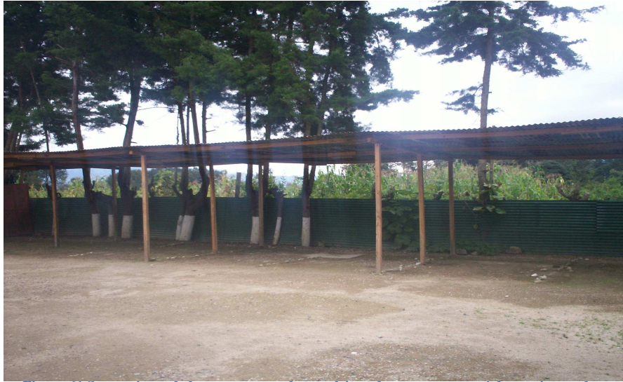
Figura 61 Saneamiento de bases compactadas en el área de parqueo y maniobras número dos.
