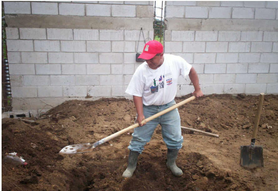
Figura 51 Acá se observa el proceso de levantado de la pared y fundición de columnas del muro perimetral.
