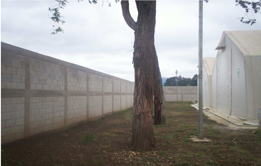
Figura 57 Vista panorámica de la parte trasera de la bodega de INDECA concluido el muro perimetral, nótese la diferencia con respecto a la figura No 49 de este documento.
