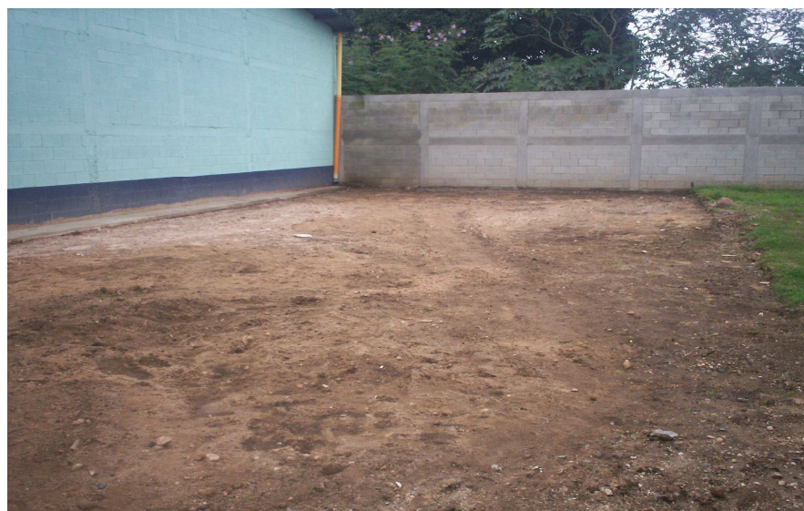
Figura 55 Proceso de habilitación de la tierra para el engramamiento después de la finalización del muro perimetral.
