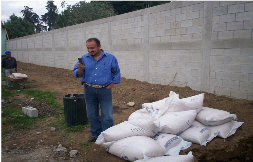
Figura 53 Avance del muro perimetral y acarreo de materiales de construcción y supervisión de la obra de parte de la empresa y de INDECA.
