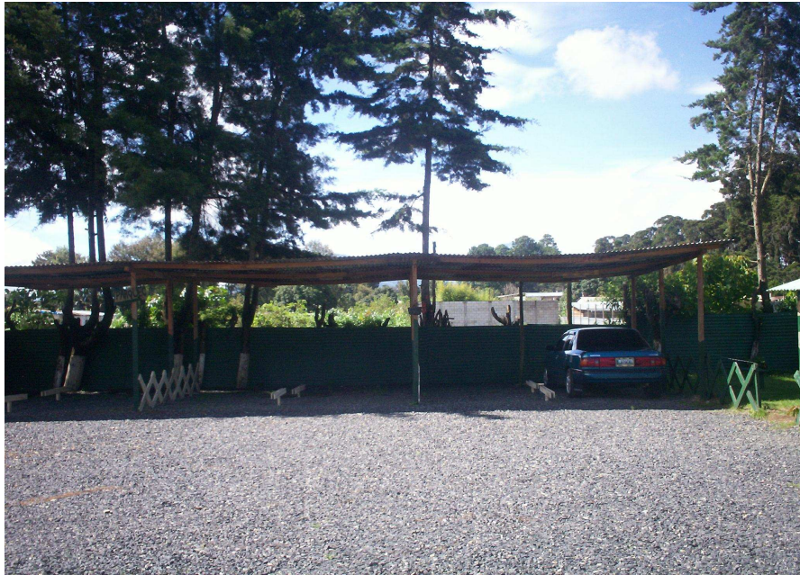
Figura 64 Área de parqueo número dos habilitada y aplicada la segunda fase de tendido de pedrín.
