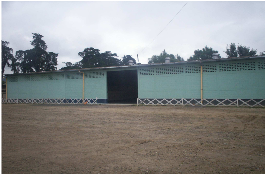
Figura 62 Nivelación y compactación del suelo cemento previo al tendido de pedrín en el parqueo y maniobras número dos
