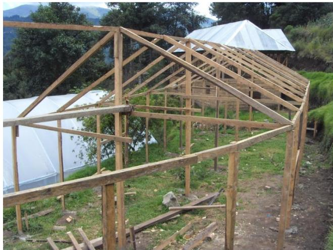
Figura 6. Armazón del invernadero utilizando madera de la comunidad
