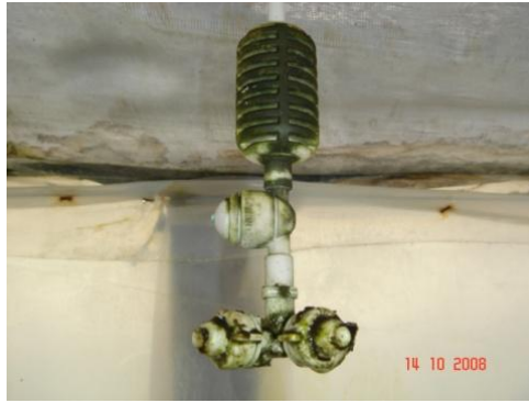
Figura 11: nebulizadores sucios con algas.
