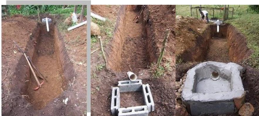
Figura 26. Excavación de la fosa y Construcción de las piletas de entrada y salida.
