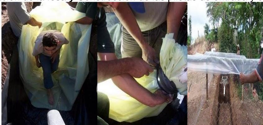
Figura 27. Preparación de la bolsa para el digestor, La tubería de la entrada de PVC se inserta en un extremo del tubo de plástico y Protección y cierre.
