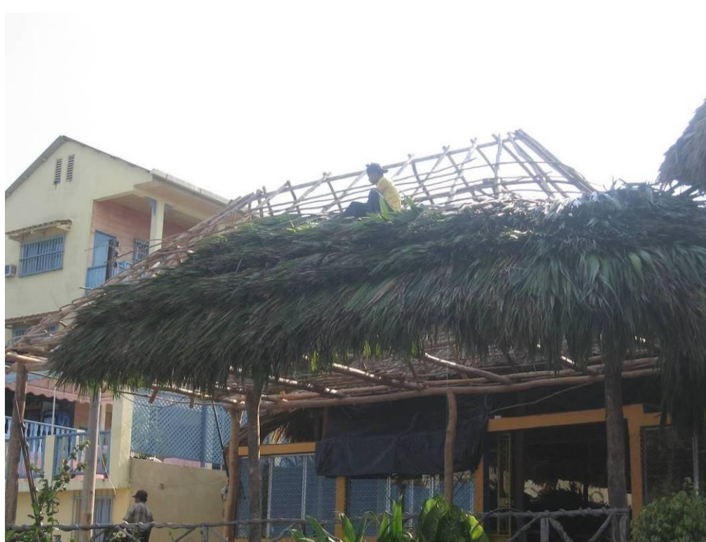
Figura 35. Instalación de techo de guano en infraestructura turística, Flores, Petén.
