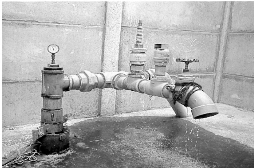
Figura 28A CABEZAL (MANIFUR), DE LA BOMBA SUMERGIBLE EN EL PROYECTO DE MINIRIEGO ALAMEDA II
