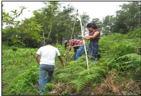
Figura 36. Trazado y estaqueado de curvas a nivel.
