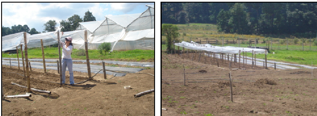
Figura 25. Colocación de techos plásticos en Utz Samaj
