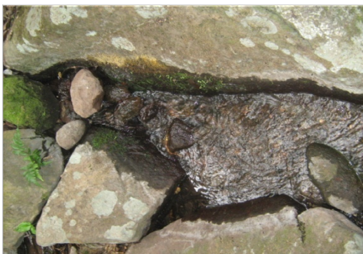
Figura 1.2 Localización del nacimiento de agua que está ubicado en la parte baja de la aldea que surte de agua a las fincas vecinas.
