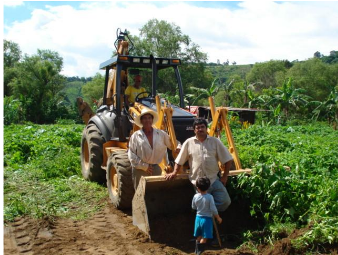
Figura 29 Utilización maquinaria pesada.
