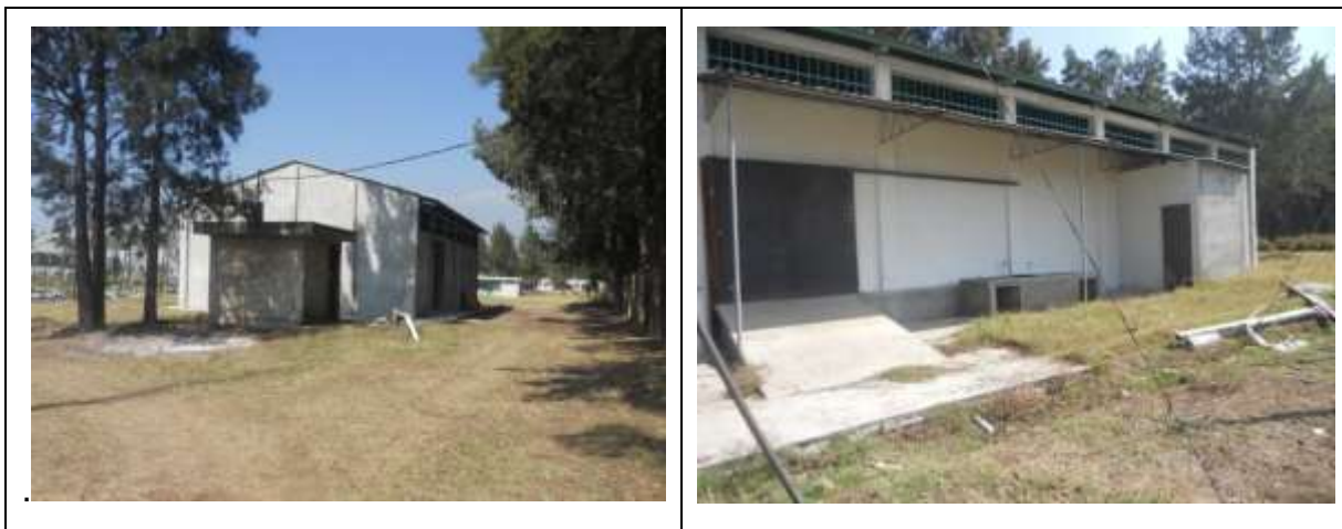
Figura 25. Instalaciones para el centro de acopio. Fotos W. Herrera 2010.
