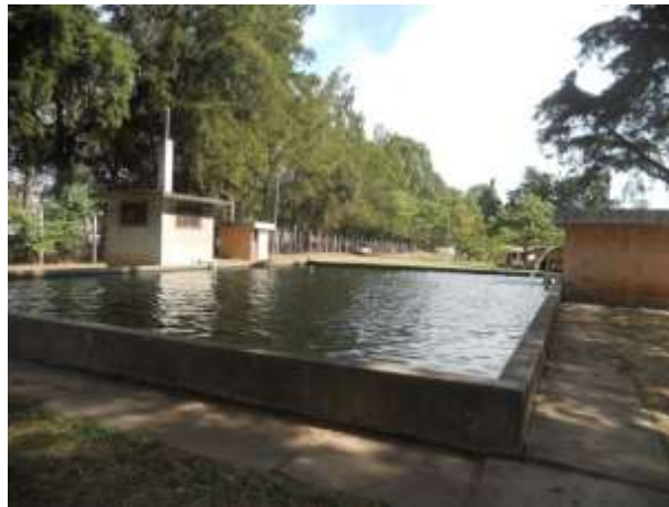
Figura 8. Tanque de captación y distribución y casetas de las bombas. Foto W. Herrera 2010.
