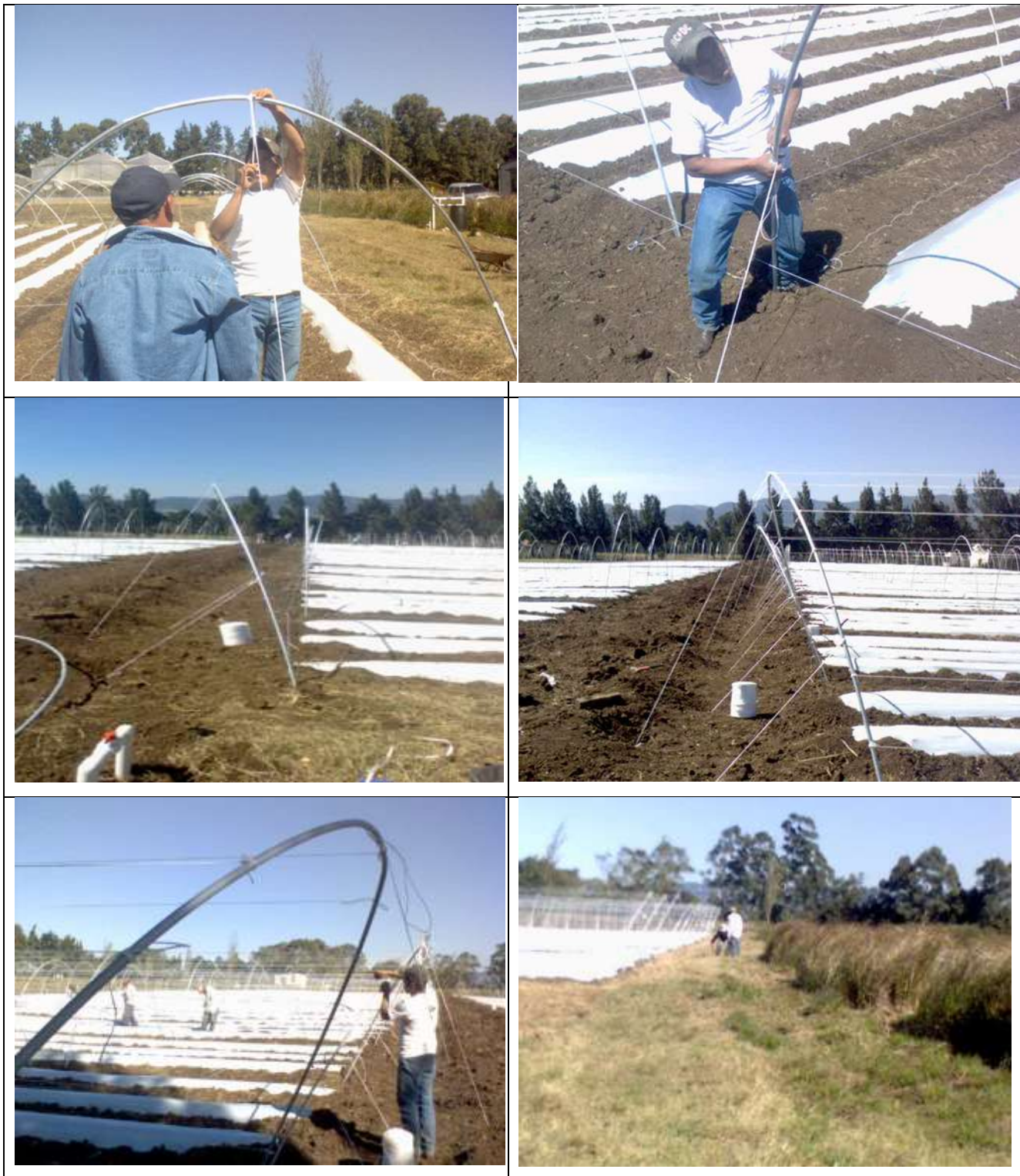
Figura 57. A) y B) Tensión de los arcos externos del macrotúnel, el del centro sujeto al suelo con pin a 1.20 m. las orillas a 0.90 m. C) y D) Forma como debe hacerse la tensión de los arcos externos. E) y F) Se realiza lo mismo en todas las cabeceras de los macrotúneles. Fotos de Walter Herrera, 2010.
