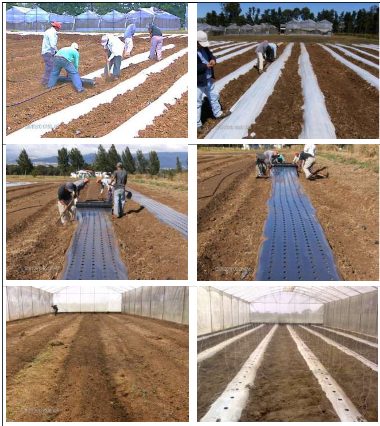
Figura 48. A y B) Colocación de acolchado plástico plata-blanco en surcos para cultivos de chile y tomate. C y D) Colocación de acolchado plástico plata-negro en camas de cebolla. E y F) Colocación de acolchado plástico plata-blanco en invernaderos. Fotos de Walter Herrera 2010.
