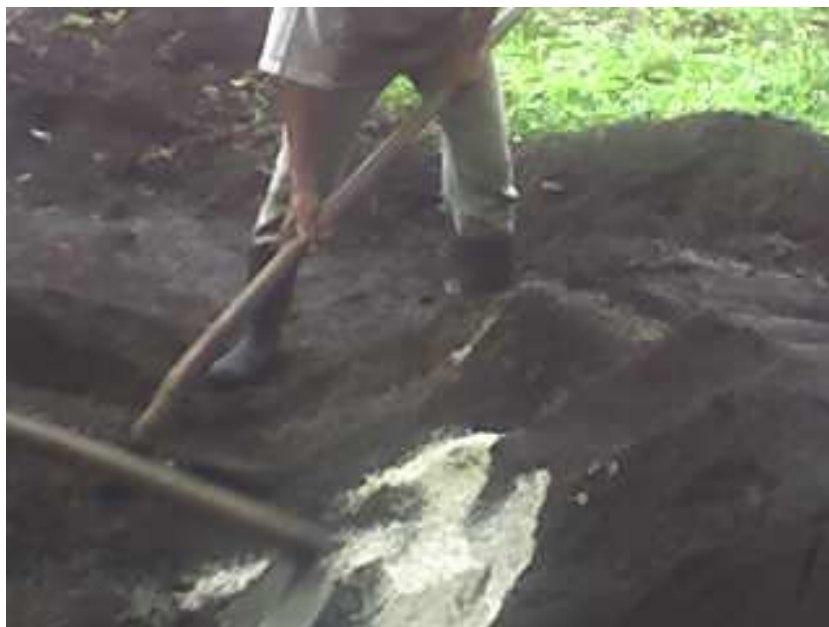
Figura 3-1A Preparación del sustrato (Tierra, arena y brosa)
