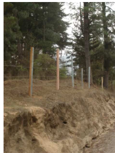
Figura 34. Protección de fuentes de agua La esperanza Quetzaltenango
