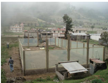
Figura 36. Construcción de Invernadero Chuicavioc Quetzaltenango
