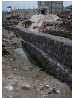
Figura 33. Construcción de gaviones Parracana La esperanza Quetzaltenango
