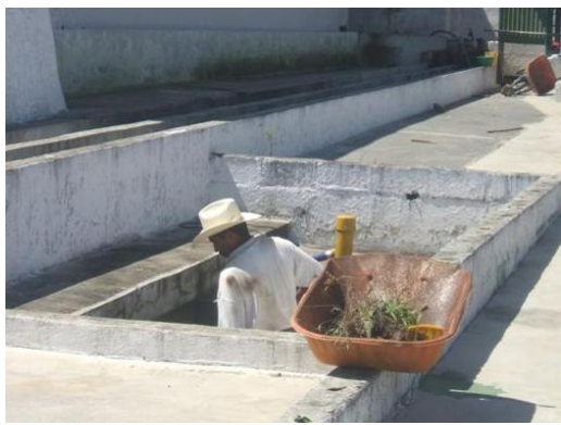
Figura 13 Caja y decantador para el tratamiento de aguas residuales producto del beneficiado.
