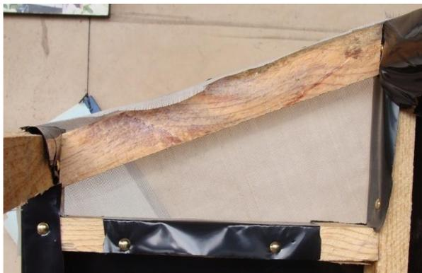
Figura 18. Triángulo de madera forrado con malla de mosquitero.
