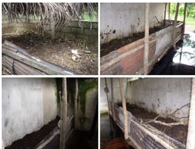
Figura 37. Construcción de las aboneras
