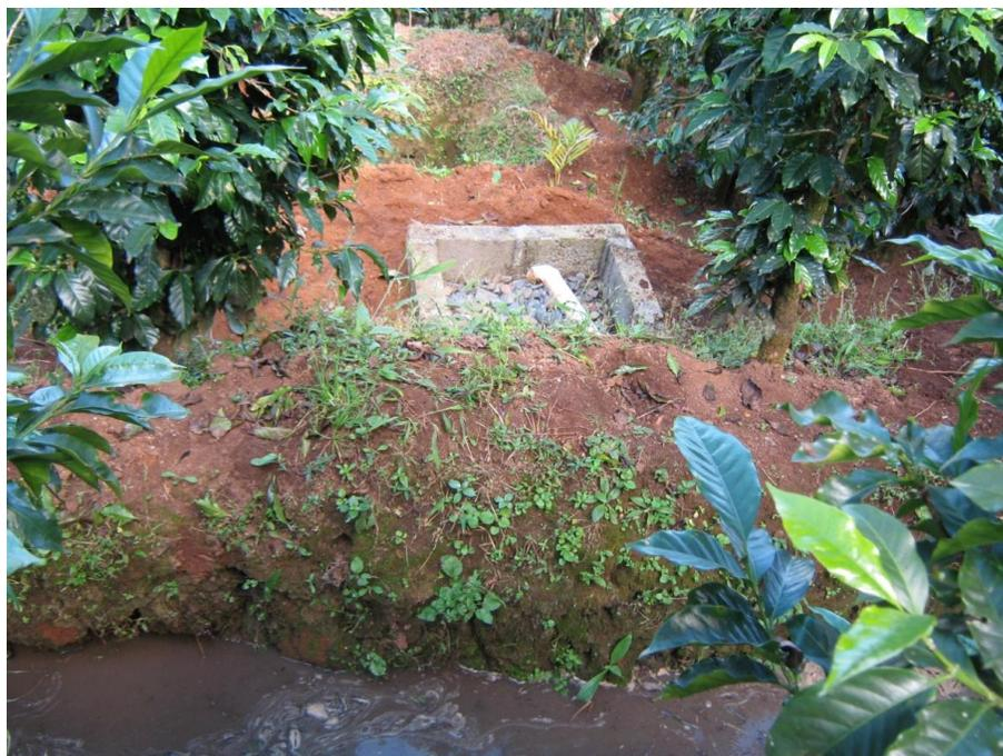
Figura 22. Fotografía de Filtro de Arena y Piedrín del beneficio no tecnificado
