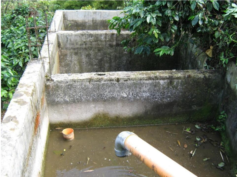
Figura 16. Fotografía de Fosas de Aguas Mieles del beneficio semitecnificado
