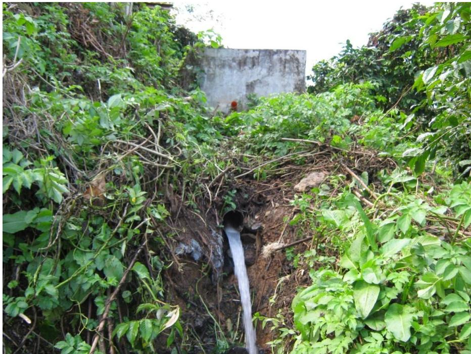
Figura 17. Fotografía de Salida de Aguas Mieles del Sistema de Tratamiento del sistema semitecnificado
