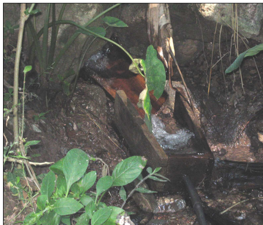
Figura 12. Captación de agua en nacimiento de Hoja Blanca. Fuente: Elaboración propia
