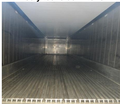
Piso y techo del interior
