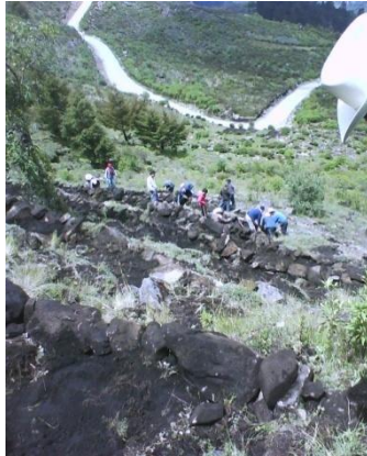
Consturcción de Muros de Piedra
