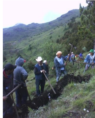
Zanjas de Infiltración
