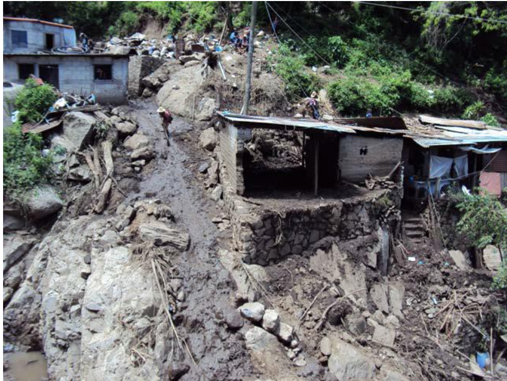
Figura 11. Vista de la parte inferior del deslizamiento.
