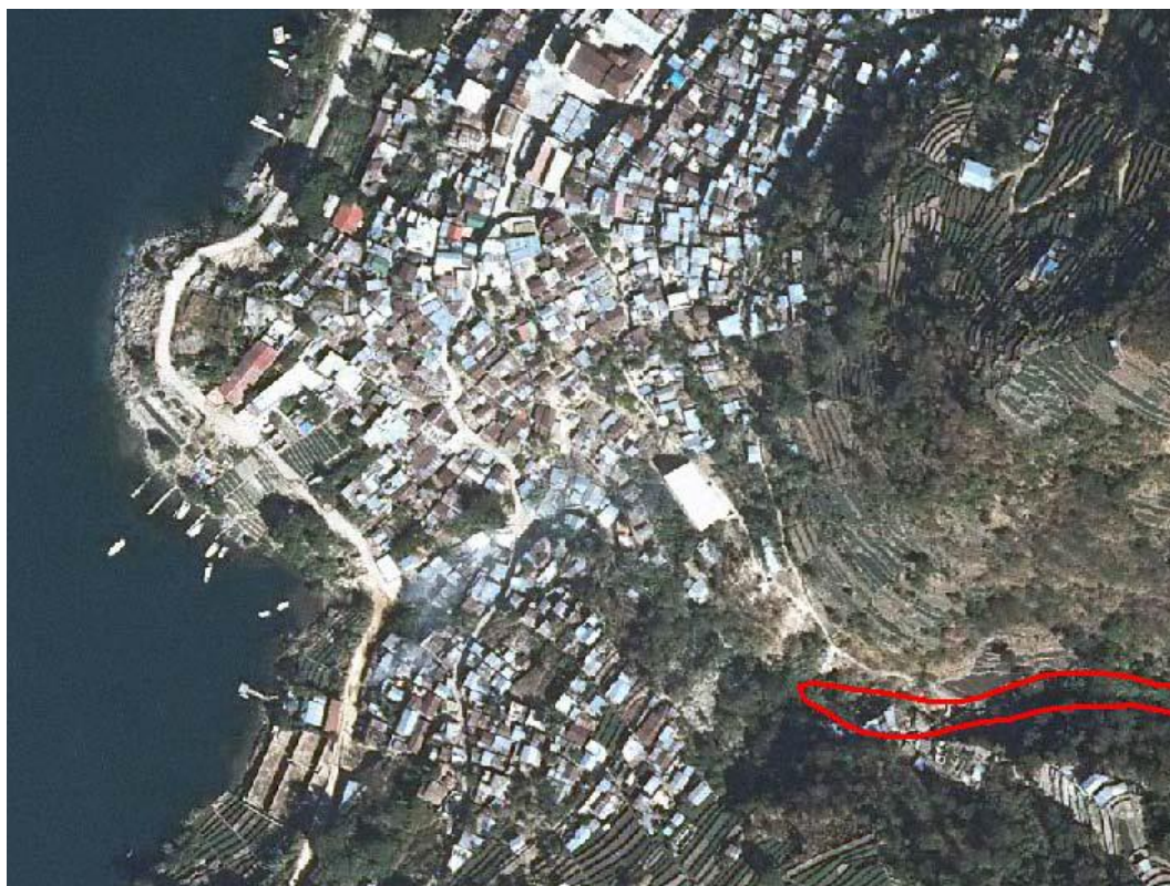
Figura 10. Ortofoto (2006) donde se observa el área afectada por el deslizamiento. (Fuente: Geólogos del mundo)
