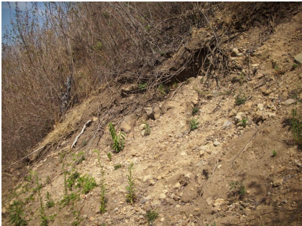
Figura 12. Vista de un área de deslave con una pendiente de 56%.
