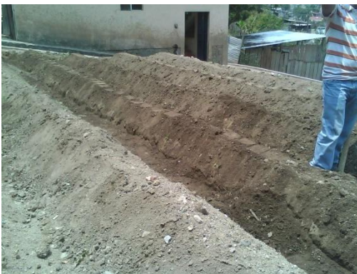
Figura 26. Preparación de camellones.
