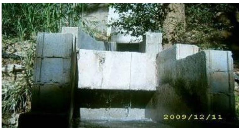
Figura 42. Planta de tratamiento
