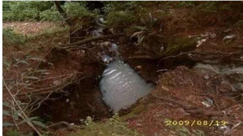
Figura 6. Contaminación al ambiente por falta de drenajes
