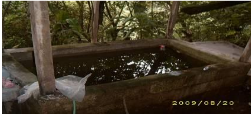
Figura 3. Almacenamiento del agua de manantial
