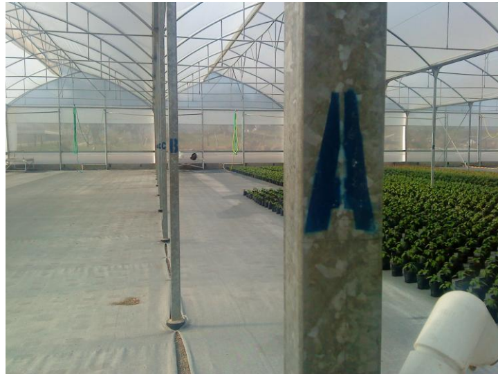
Figura 2. Marcado de las letras en cada uno de los polines.
