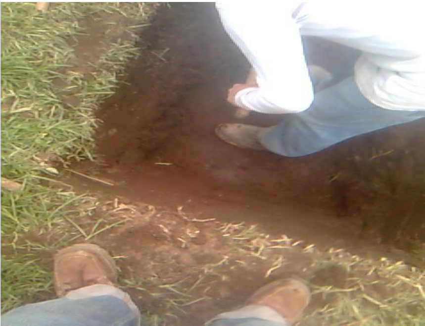
Figura 14. elaboración del agujero previo al llenado con los materiales.
