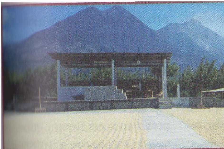
Fuente: Anacafé Figura 16. Patios de secado de concreto
