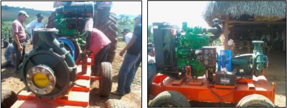
Figura 33. Control y revisión de equipo para riego
