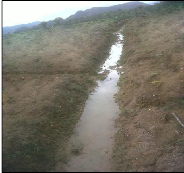
Figura 12. Drenaje primario y secundario
