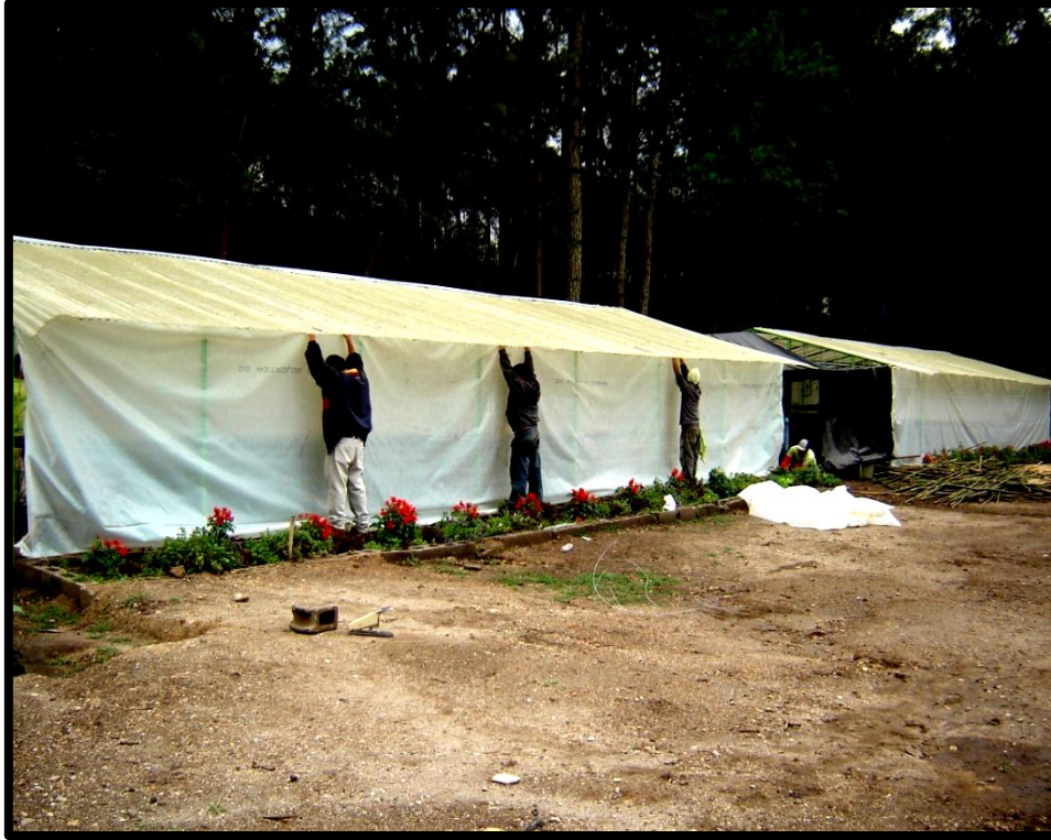
Figura 25. Vista de los trabajos realizados a las instalaciones de los invernaderos.
