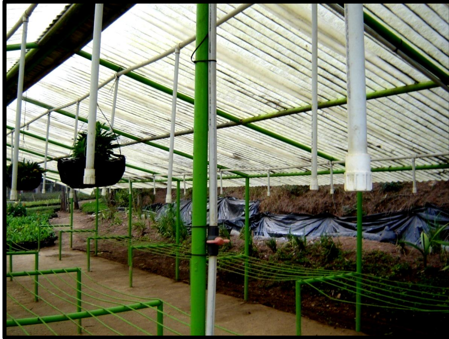
Figura 22. Condiciones en que se encontraban los invernaderos.
