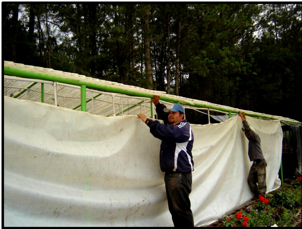
Figura 24. Colocación del plástico al invernadero.
