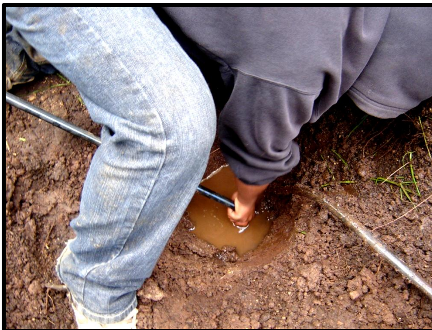
Figura 55. Colocación de las mangueras de poliducto a las tuberías principales.
