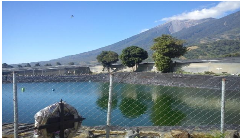
Figura 5. Vaso de almacenamiento o reservorio de agua para su utilización en la plantación de hoja de cuero.
