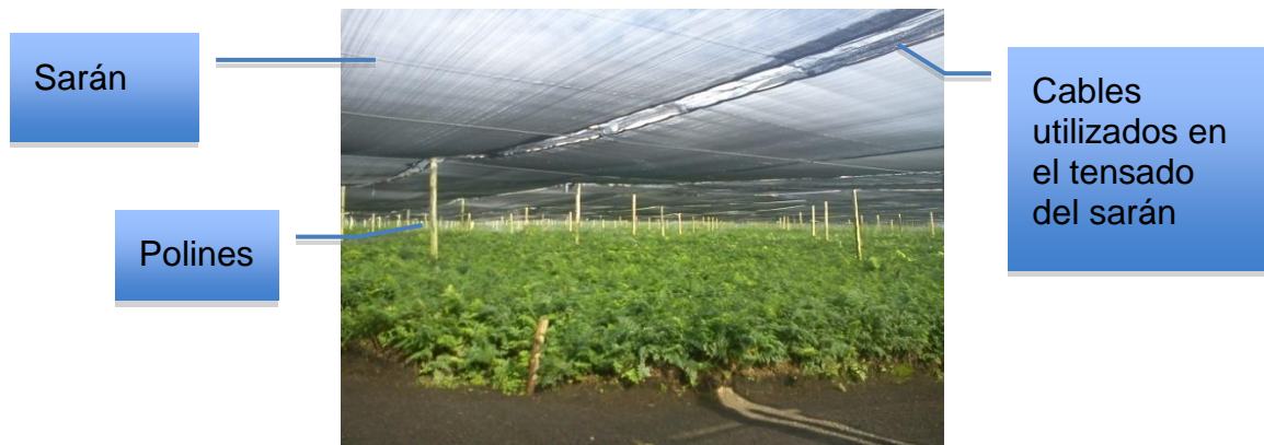
Figura 3. Componentes de la estructura utilizada como umbráculo en la finca Costa Sol S.A.
