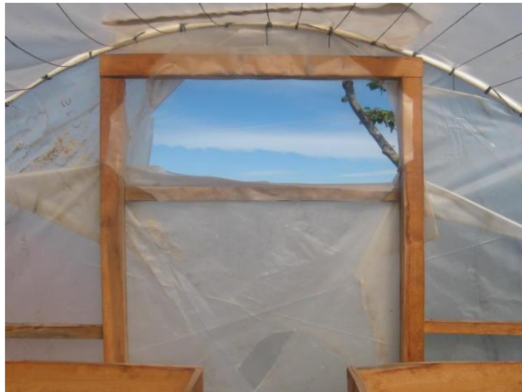
Figura 51 Cobertor plástico totalmente reparado.
