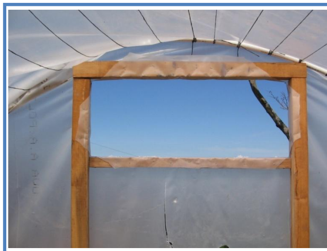
Figura 22 Salida de aire cálido y vapor de agua superior.
