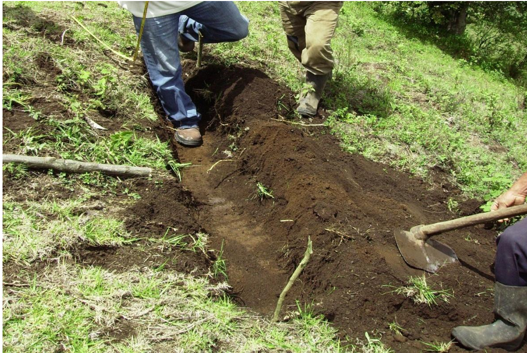
Figura 30. Construcción de Acequia
