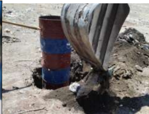
Figura 8. Instalación de chimeneas
