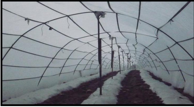
Figura 16 Largueros laterales en macro túnel para reforzar la estructura
