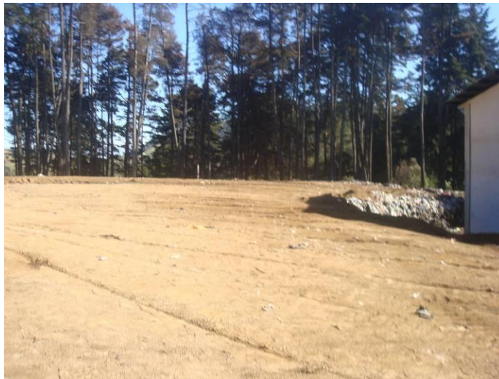
Figura 18. Relleno cubierto después de la descarga diaria de residuos sólidos.
