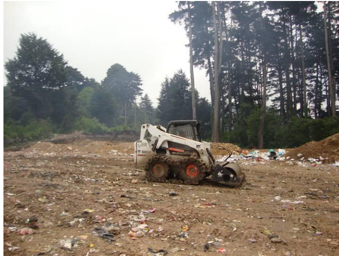
Figura 17. Mini cargador compactando la cobertura aplicada al relleno.
