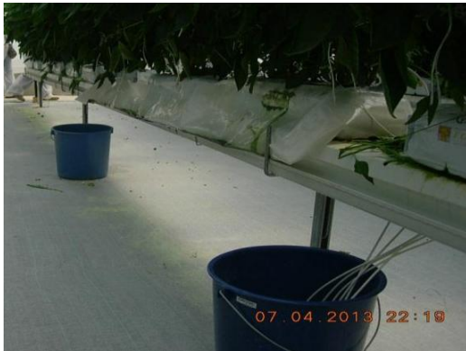
Figura 7: Estación de riego y drenaje.
