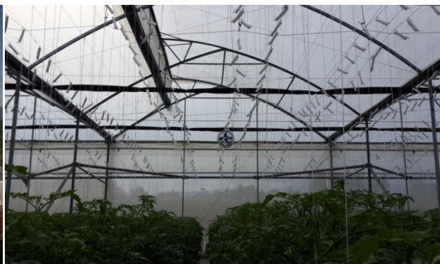
Figura 50: Ventilación interna (Tratamiento sin provisión de CO 2 ).
