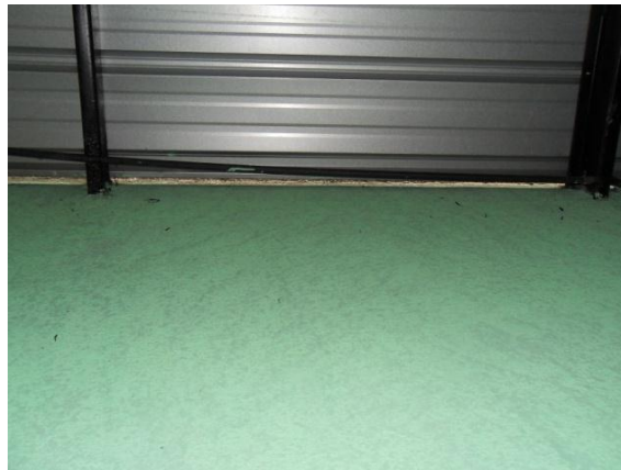
Figura 51. Pequeña abertura entre la pared y el techo del laboratorio
