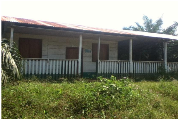
Figura No 4. Instalaciones no aptas para cría de parasitoides
