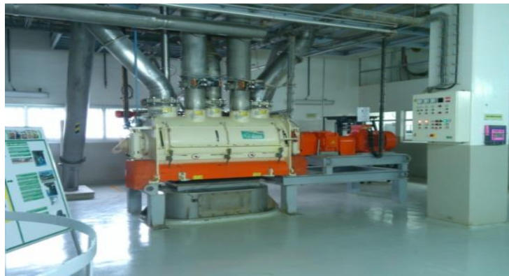
Figura 6. Mezcladora del centro de mezclas
