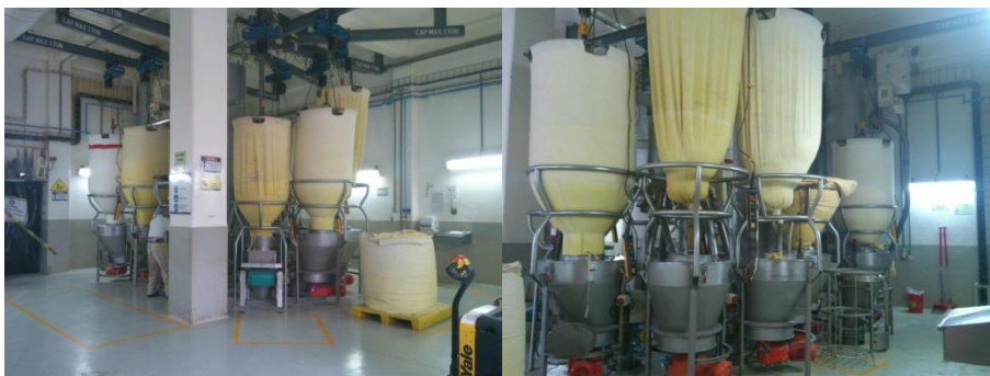
Figura 5. Sistema de tolvas que alimentan la mezcladora
