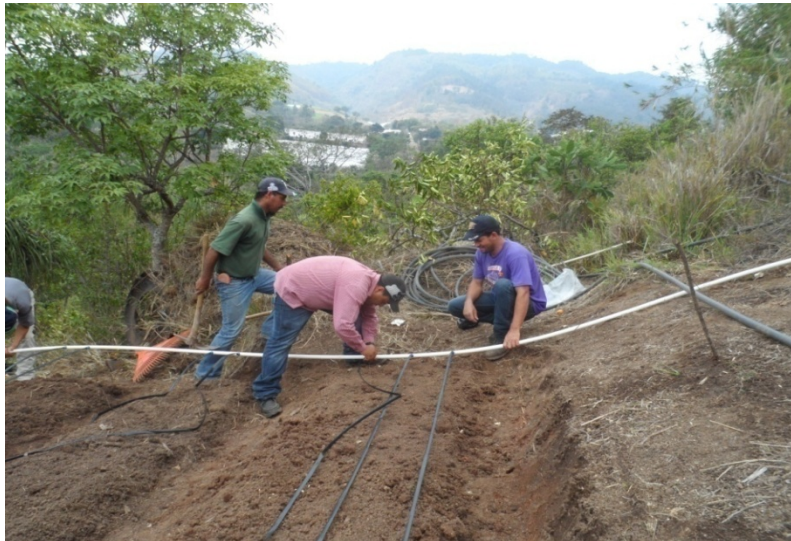
Figura 39. Instalación sistema de riego aldea San Juan Bosco. Preparación de tubería para instalación de manguera de riego.
