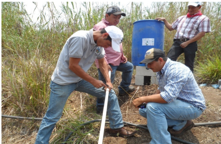
Figura 39. Instalación sistema de riego aldea San Juan Bosco. Preparación de tubería para instalación de manguera de riego.
