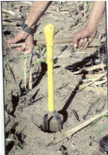
Figura 47. Perforación de pozo 3"
