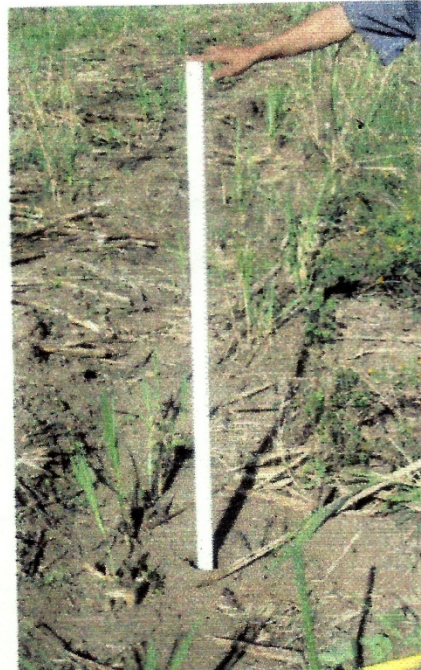
Figura 49. Inserción de la camisa y del tubo ranurado.
