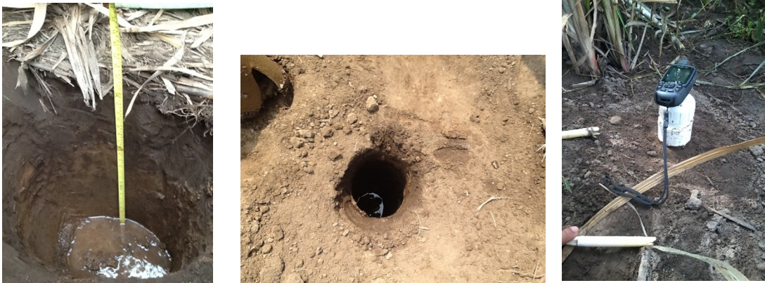
Figura 56A. Instalación de Pozos para monitoreo de Nivel Freático en puntos críticos de la zona de cultivo.
