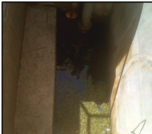
Figura 31. Antes de la colocación de las rejas
