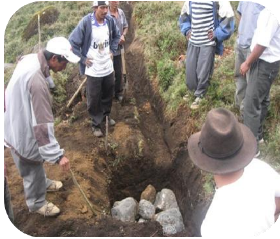
Figura 14. Elaboración de zanjas de infiltración, para conservación de suelos, en la comunidad de Sutquin, municipio de Tacaná, departamento de San Marcos
