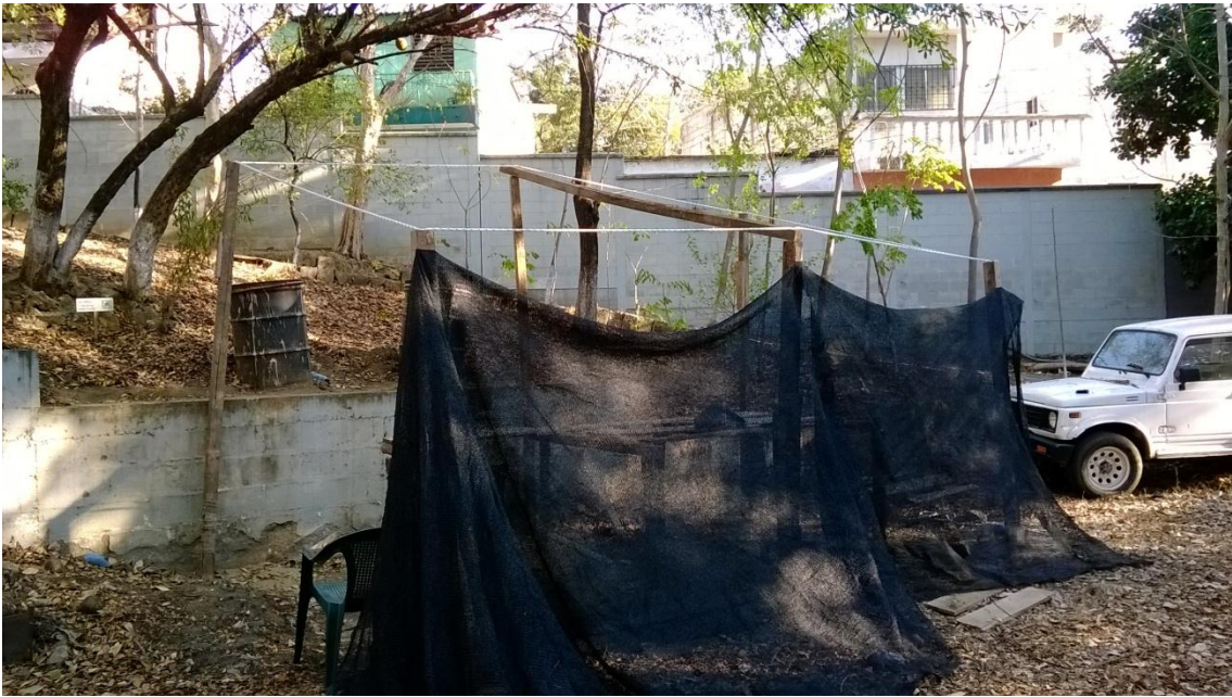
Figura 35. Instalación del zaran para el invernadero
