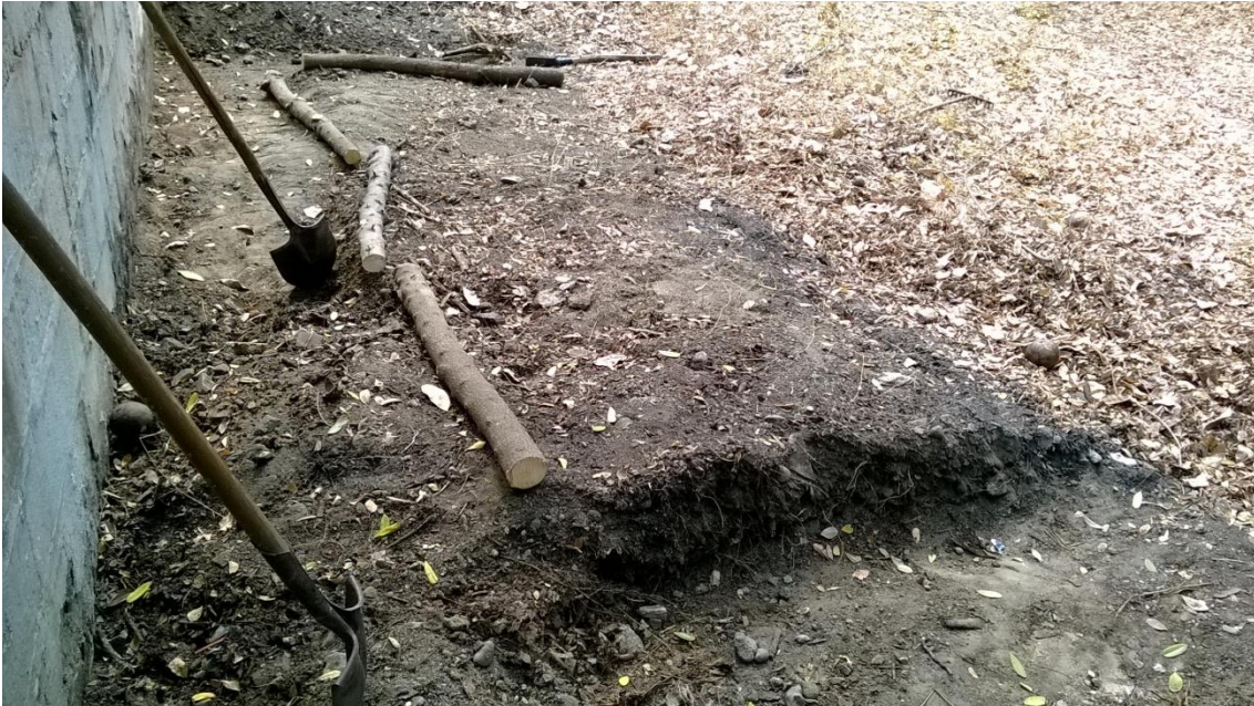
Figura 32. Preparación y nivelación del terreno para el invernadero
