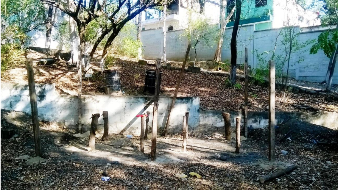
Figura 34. Colocación de los parales del invernadero
